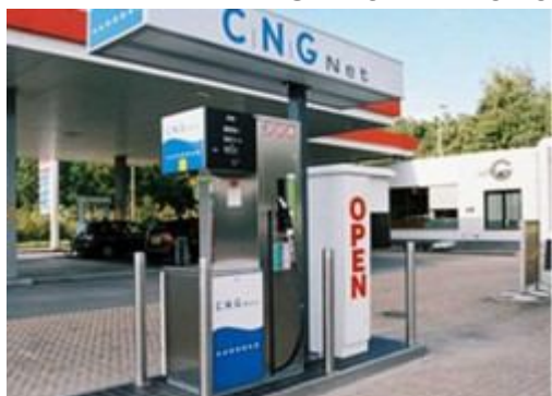
АГНКС компанії Ballast Nedam
